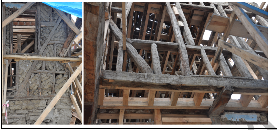
Şekil 4: Taraklı Geleneksel Sivil Mimarisinde Ahşap Çatkılı Duvarlar
