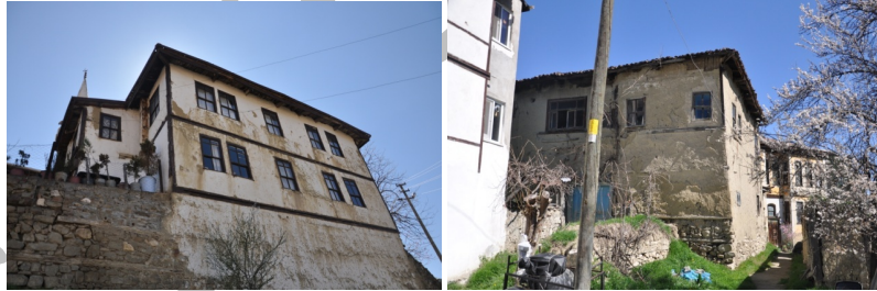
Şekil 8. Taraklı Geleneksel Sivil Mimarisinde Taş Duvar ve Hatıllar
