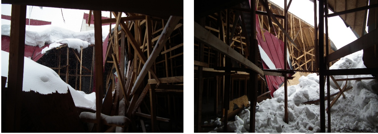
Şekil 2. Çöken ahşap çatı
