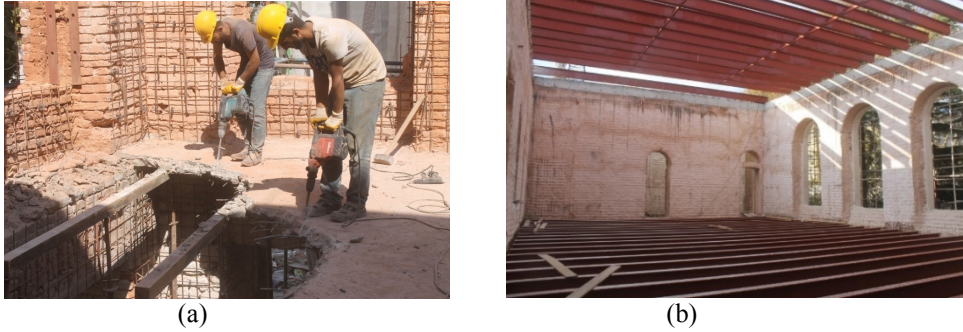
Şekil 22. Restorasyon Döşeme Söküm (a) ve Yapım Aşamaları (b); (Akka, Mim., 2015)
